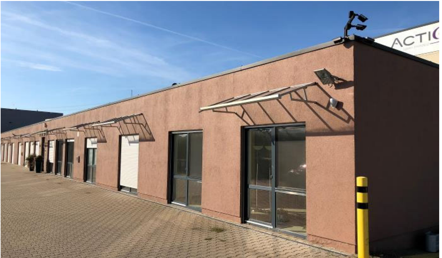
Bürogebäude mit Kameraüberwachung
