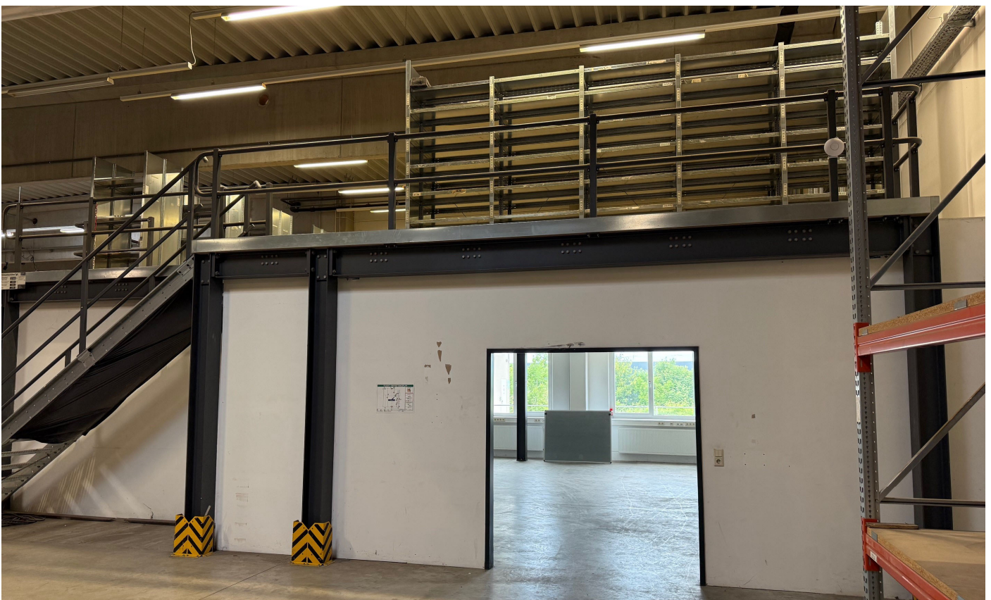
Halle 1 - Meisterbüro und Aufgang zur Fläche Kleinteilelager
