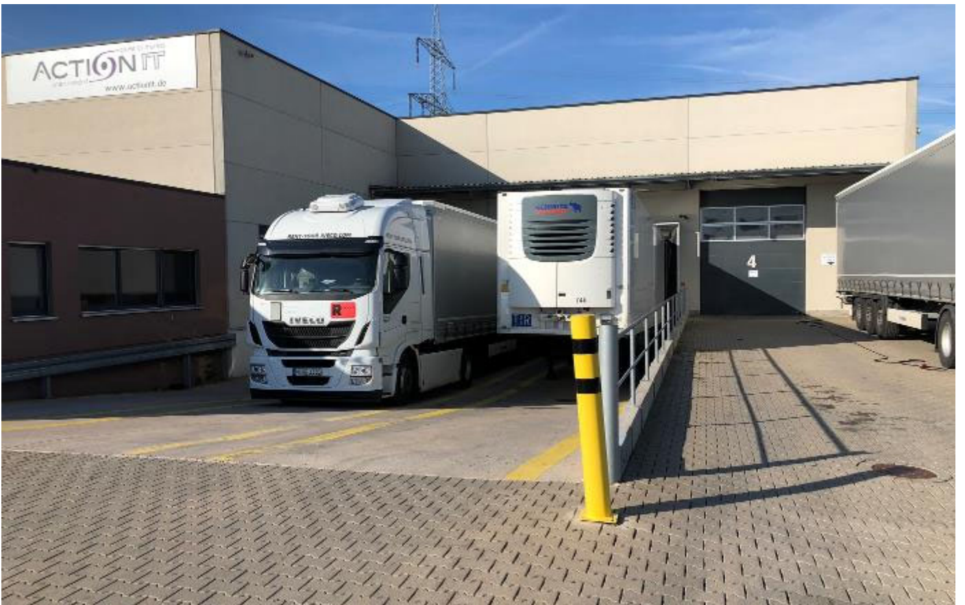
Rampenandienung und ebenerdige Zufahrt
